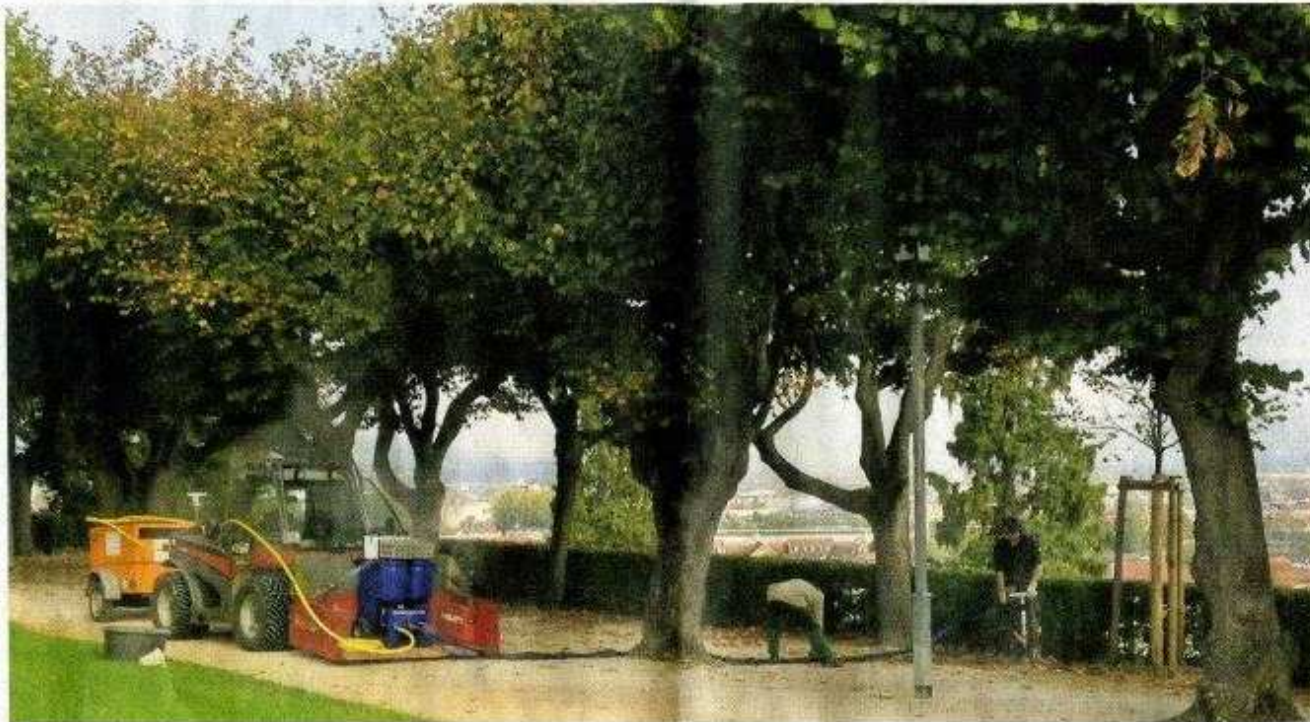
Mit Bohrungen und Injektionen erhielten die geschädigten Bäume im Wurzelbereich Luft und Wasser.
